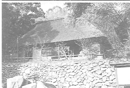
●上：地域の住民ボランティアによって、囲炉裏に火がおこされる。●下：この民家は愛媛県の南、小田町の深い谷脇の急斜面に建っていた(旧河野家住宅)
