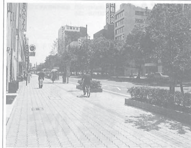
高松市中央通りプロムナード(透水性舗装用れんが PB-Y)
