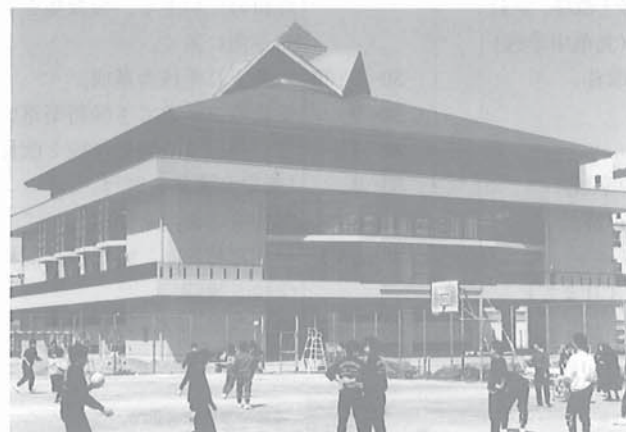
●体育館 63年1月完成したばかりの体育館、一階に武道場を備えた三階建て。
