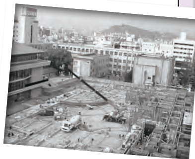
工事中の第1グラウンド (写真：卒業生提供)
