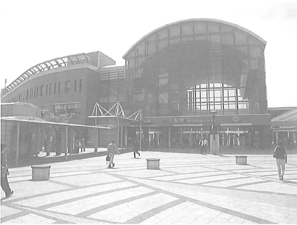
東側から撮影（駅舎）
