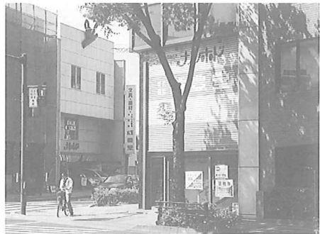
南東側より撮影
