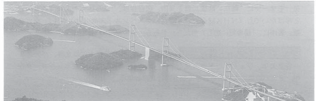
来島海峡大橋
